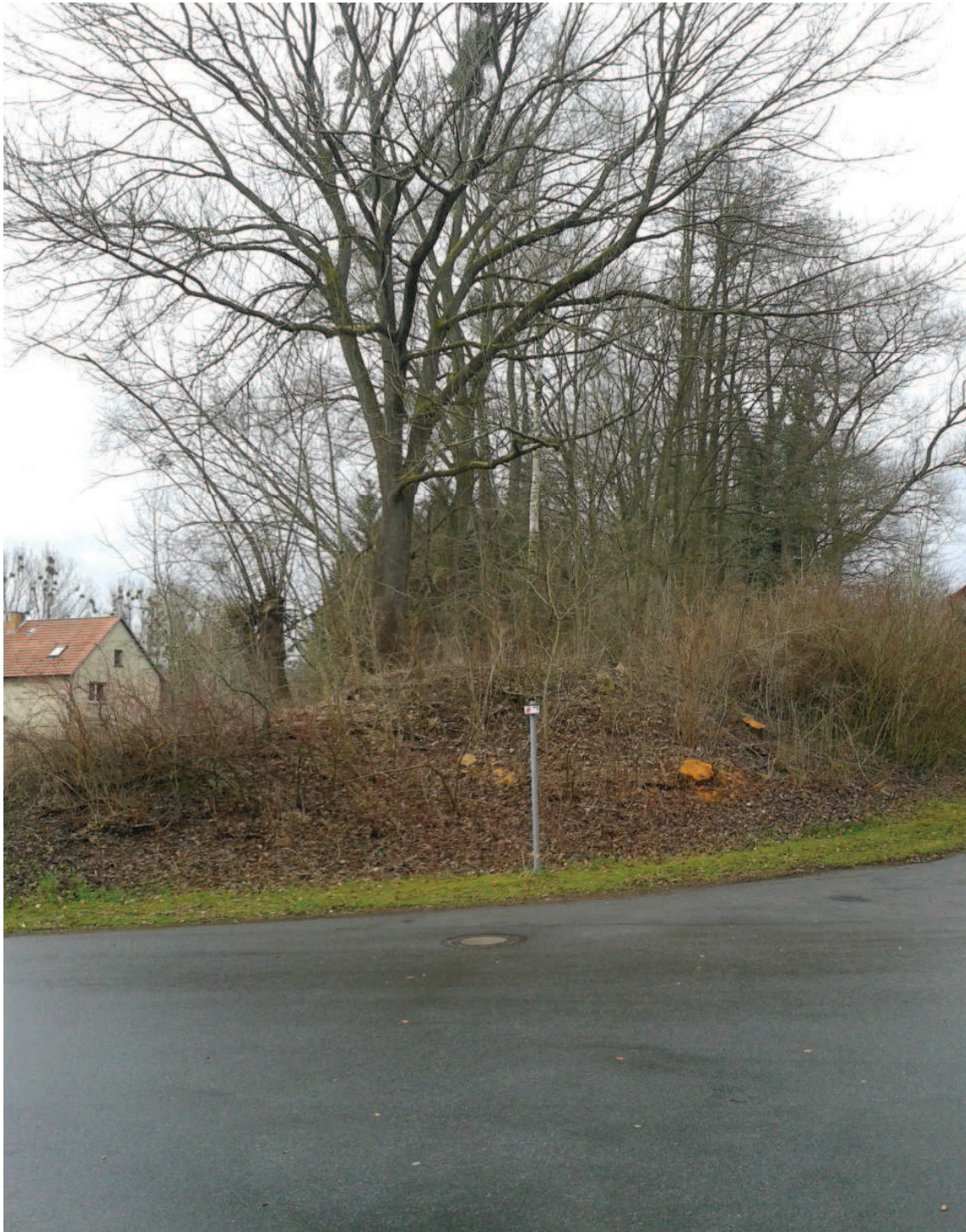
Abbildung 10: Bereich der Einhausung am Bahndamm an der Brückenstraße
